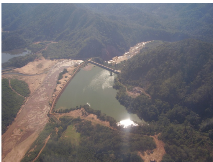
Figura S28 El río Caraparí cruza el embalse de Itiyuro y descarga directamente sobre la cresta de la obra de alivio en 2006. Fuente Ing P.García Bess 2006.
