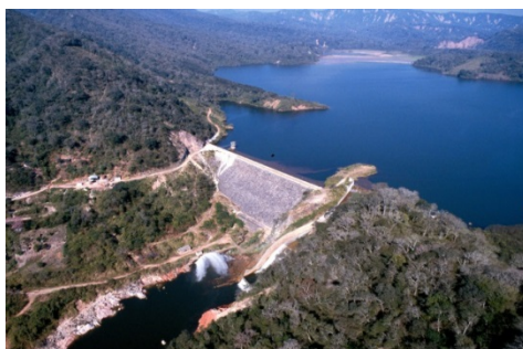
Figura S23 Dique y embalse Itiyuro en el año 1982. Fuente E.Malagnino 1990.
