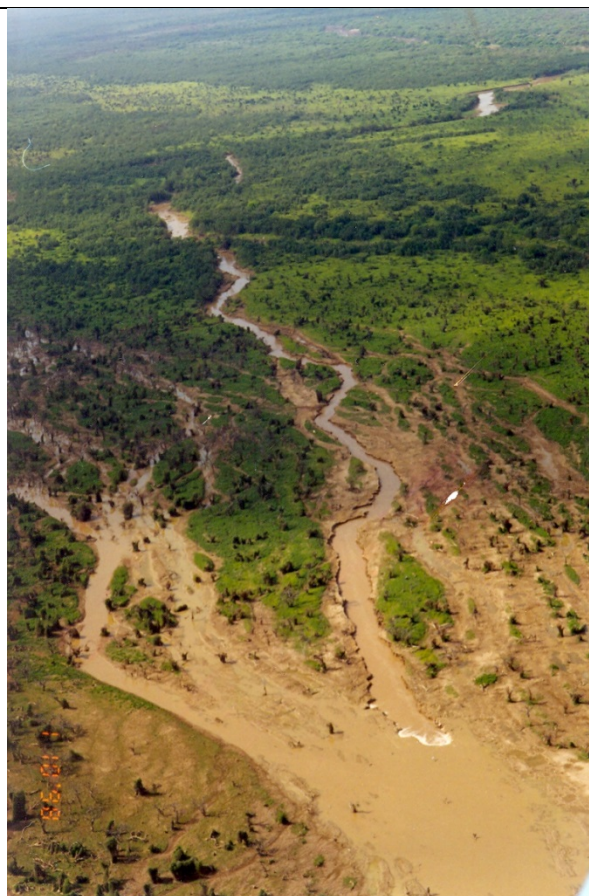
Figura S22 Erosión retrógrada en el enlame de una crecida del río Pilcomayo, enero 1998.
