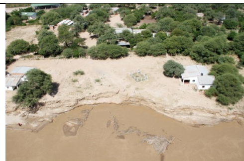
Figura S18 Erosión de ribera en la estación de aforo Misión La Paz
