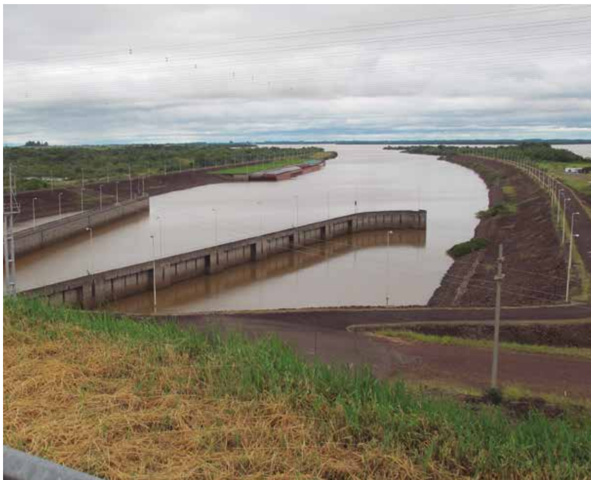
O sistema de transposição da barragem binacional Yacyretá permite a navegação do trecho do rio Paraná compartilhado entre Argentina e Uruguai.
