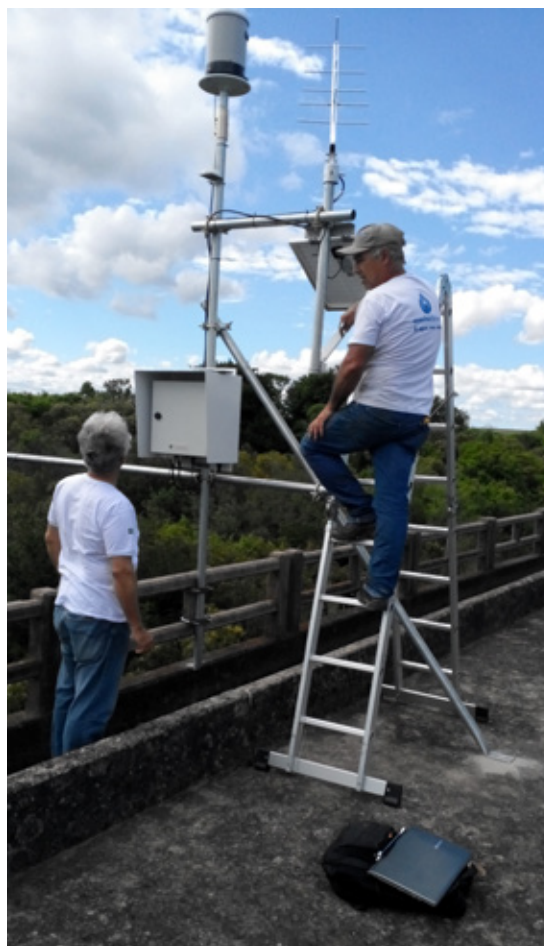
Instalación de una estación telemétrica de precipitación y nivel en el arroyo Sarandí, Brasil.
