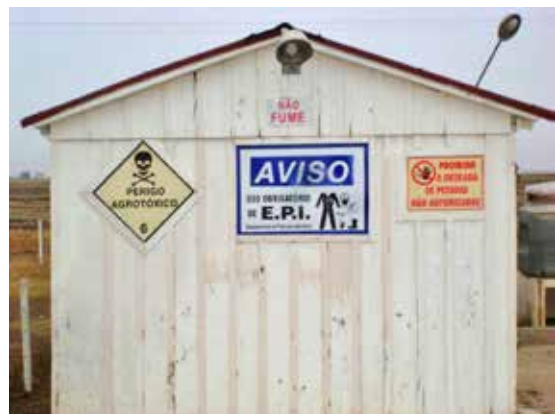
Prédio com avisos de advertência.
