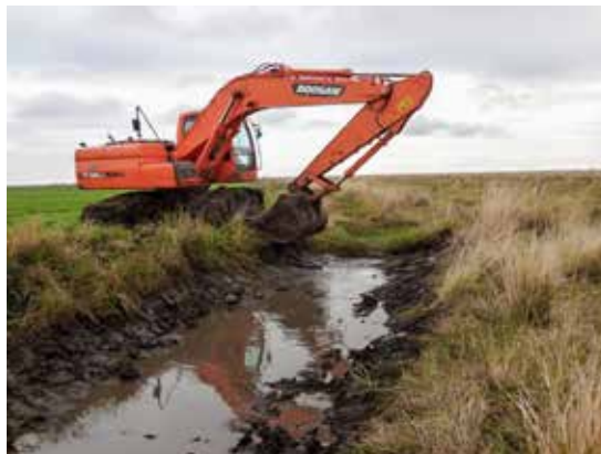
Canal sendo preparado para irrigação.
