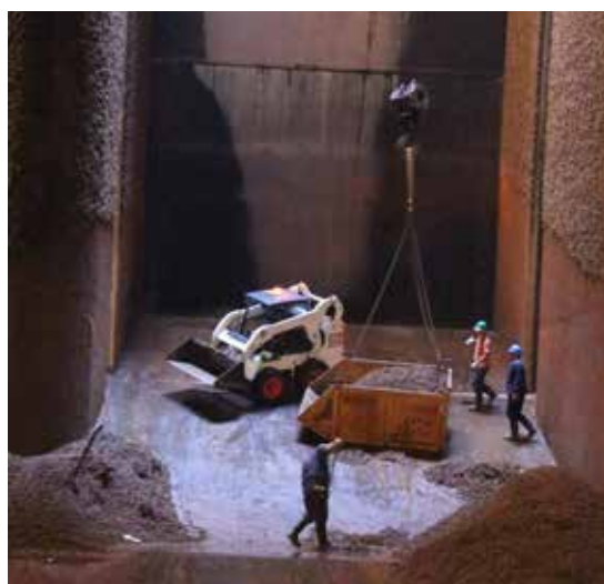
Limpieza de las paredes de las cámaras espiral de las turbinas de EBY para extraer el mejillón dorado Limnoperna fortunei
