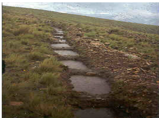
Zanjas de infiltración.
