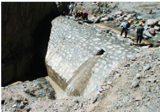
Construcción del punto fijo sobre el río Colanzulí.
