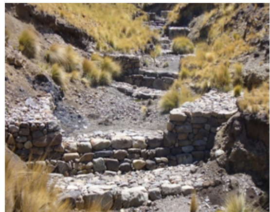
Estructuras de control de cárcavas (diques de piedra).
