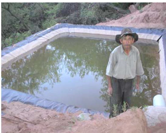
Estanque de geomembrana para almacenamiento de agua.
