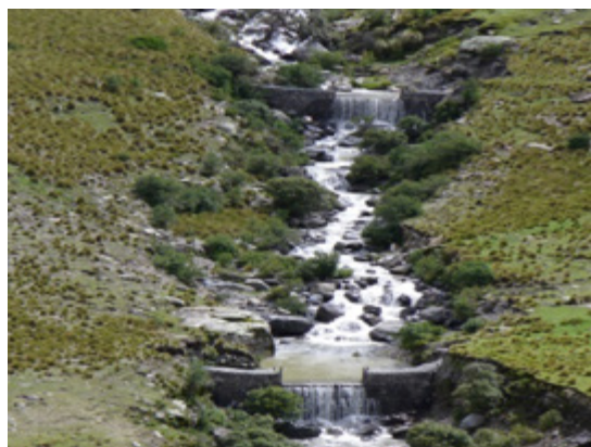
Características de los diques de control hidráulico en cárcavas.
