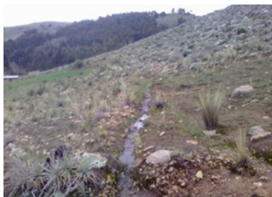
Zanjas de coronación.
