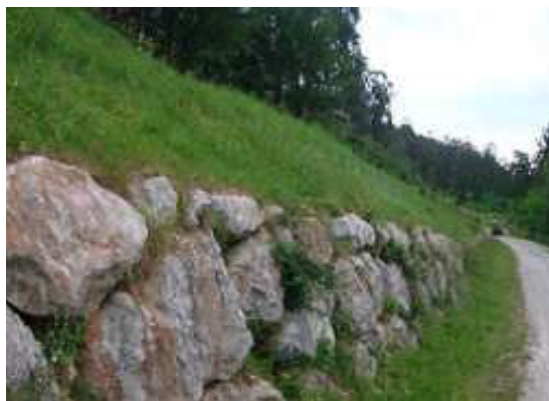
Estabilización de laderas con base de piedras, forestación y vegetación.
