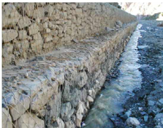
Defensa marginal de gaviones en el río Colanzulí, Iruya, Salta, Argentina.
