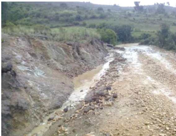
Cunetas y caminos de acceso transportando agua y sedimentos en suspensión.
