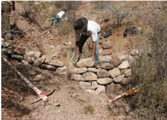
Acciones constructivas del control de cárcavas.
