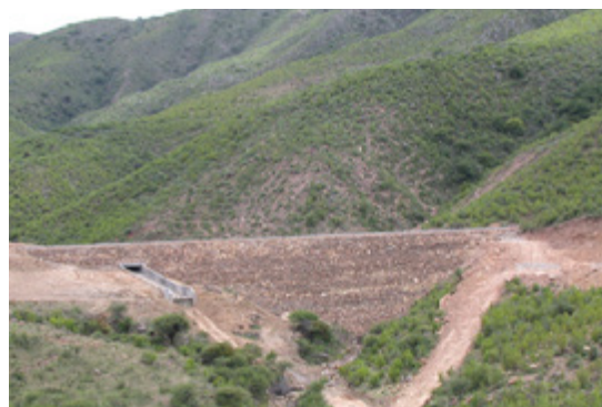
Presa de enrocado en la cuenca del río Tolomosa, Bolivia.
