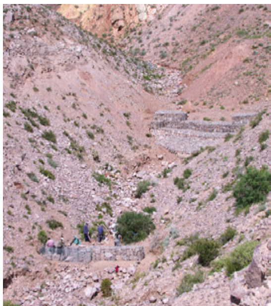
Muro de gaviones en el piedemonte de Tilcara, Jujuy, Argentina.
