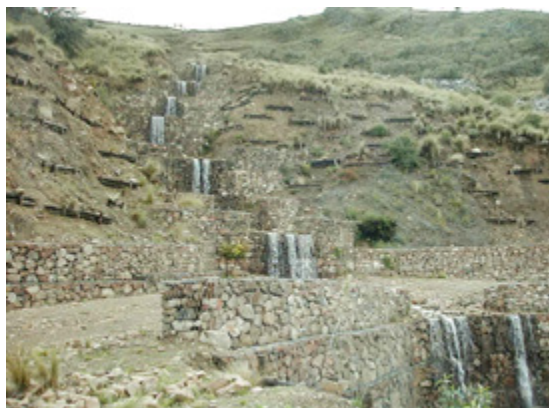
Control hidráulico en cárcavas activas.
