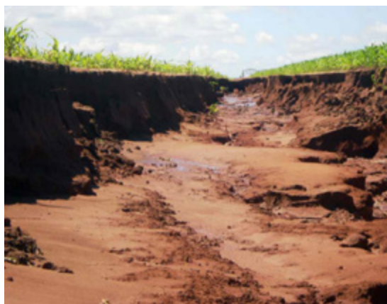
Acequia de conducción de agua.
