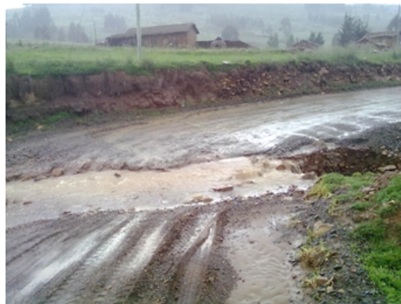
Cunetas y caminos de acceso transportando agua y sedimentos en suspensión.
