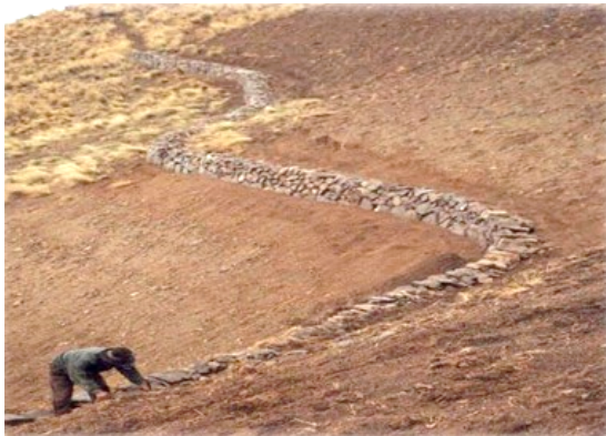
Construcción de terrazas de formación lenta en base a curvas de nivel.
