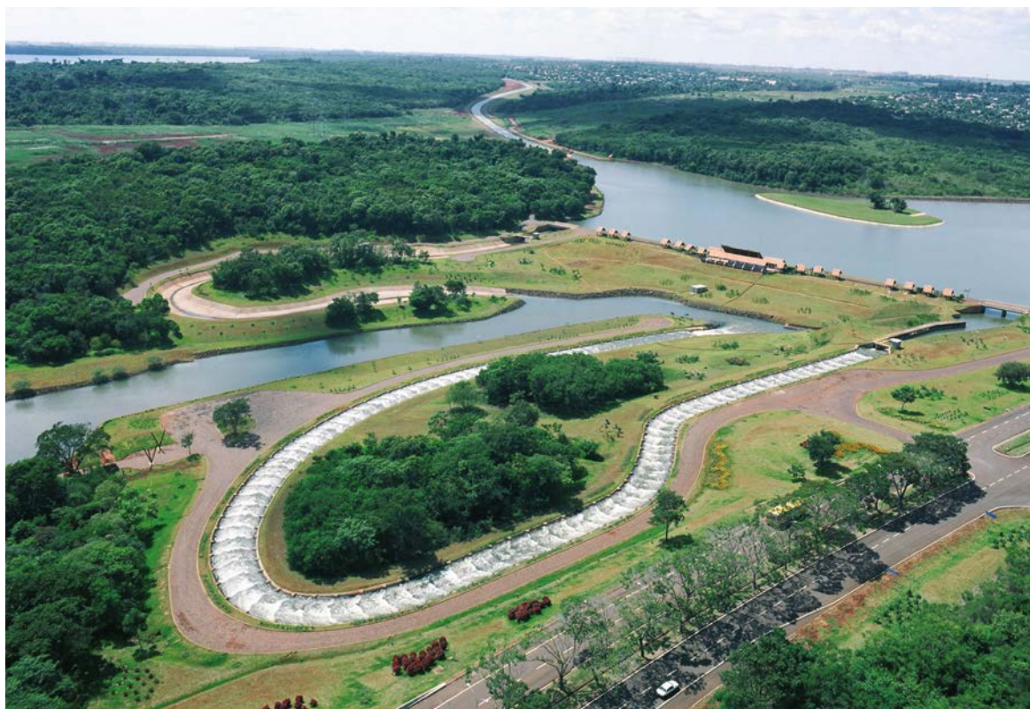
Canal de Piracema en la presa Itaipú.
