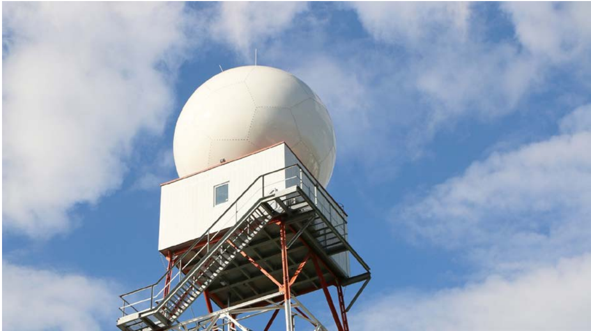
Radar del SINARAME, Argentina.
