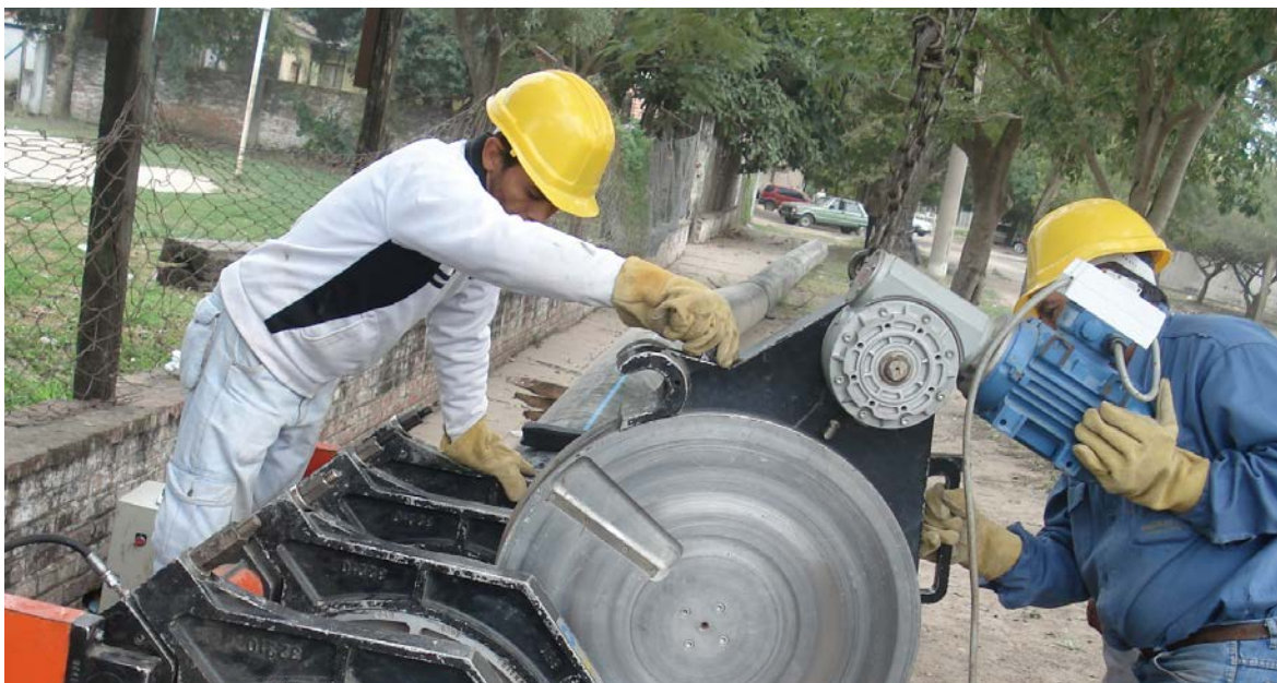
Instalación de redes troncales de agua potable.
